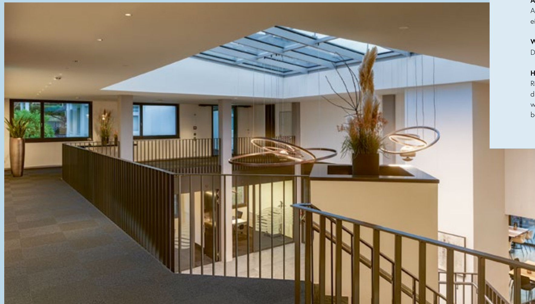
Speziell für die Klinik Seeschau angefertigt: Die beiden Ringpendelleuchten sind die Eye-Catcher in der grossen Empfangshalle. TriTec Linsenwandfluter hellen die Wände im Obergeschoss zusätzlich auf.
