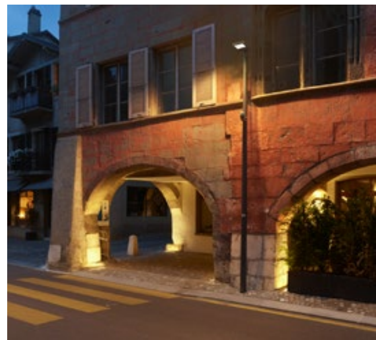
Bei den Zebrastreifen wurde zur Einhaltung der geltenden Norm eine zweiseitige Beleuchtung vorgenommen.
